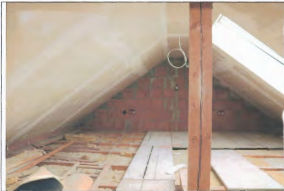
Bild 2: Blick in den hinteren Raum des Dachgeschoßes
